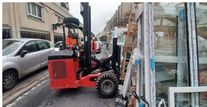
Récupération des menuiseries extérieures à Saint-Maurice
