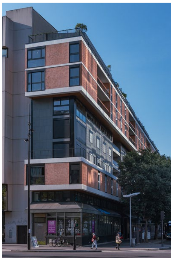
Isolation thermique par l'extérieure – bardage
